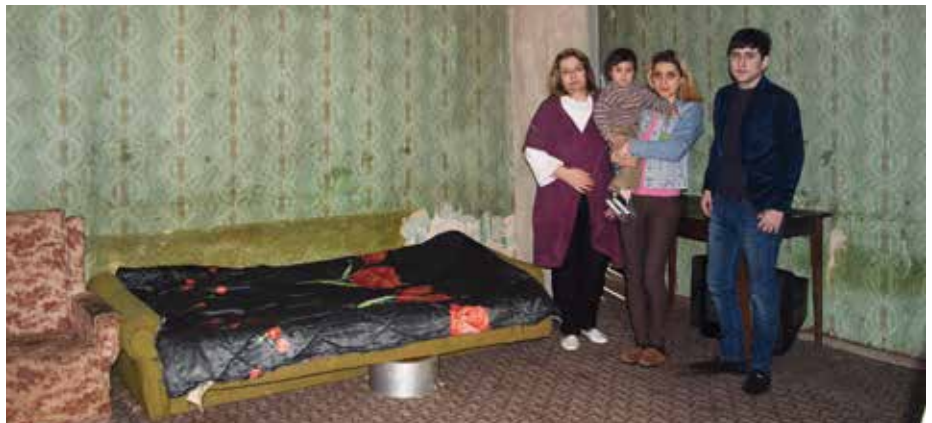
Das alte Sofa muss Familie Mkrdumjan mit einem Topf stützen, damit die Liegefläche nicht einbricht.
